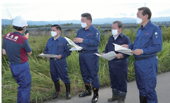
9月22日、球磨川に架かる錦町の陥没した橋梁の視察
