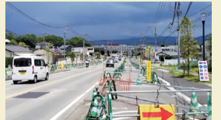
▲7月15日、県道28号4車線化の状況
