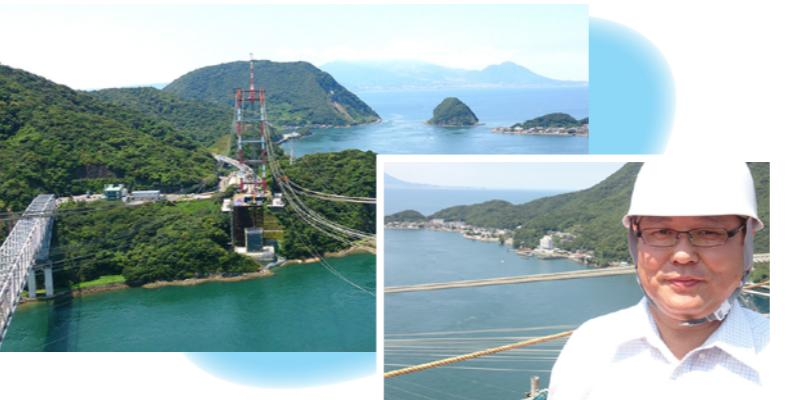
8月3日、建設常任委員会の管内視察で天草五橋の1号橋横に熊本天草幹線道路の新設橋として建設される「新天門橋(仮称)」の建設現場の視察を行ってきました。この橋は、「ソリッドドリブ中路式鋼PC複合アーチ橋」で、「ケーブルエクション斜吊工法」を取るため、両岸に大きく高い鉄塔がそびえ立っており、その天辺に仮設のエレベーターで昇り工事の全貌を拝見しました。恐怖でした。
