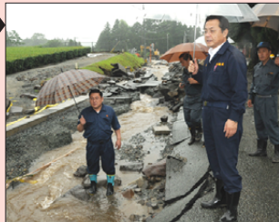
▲菊池市旭志町の道路崩壊現場
