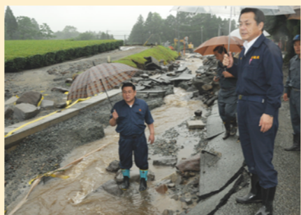
▲菊池市旭志の道路崩壊現場
